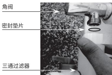
第二步、再将编织软管进水口连接到三通过滤器,用扳手拧紧
